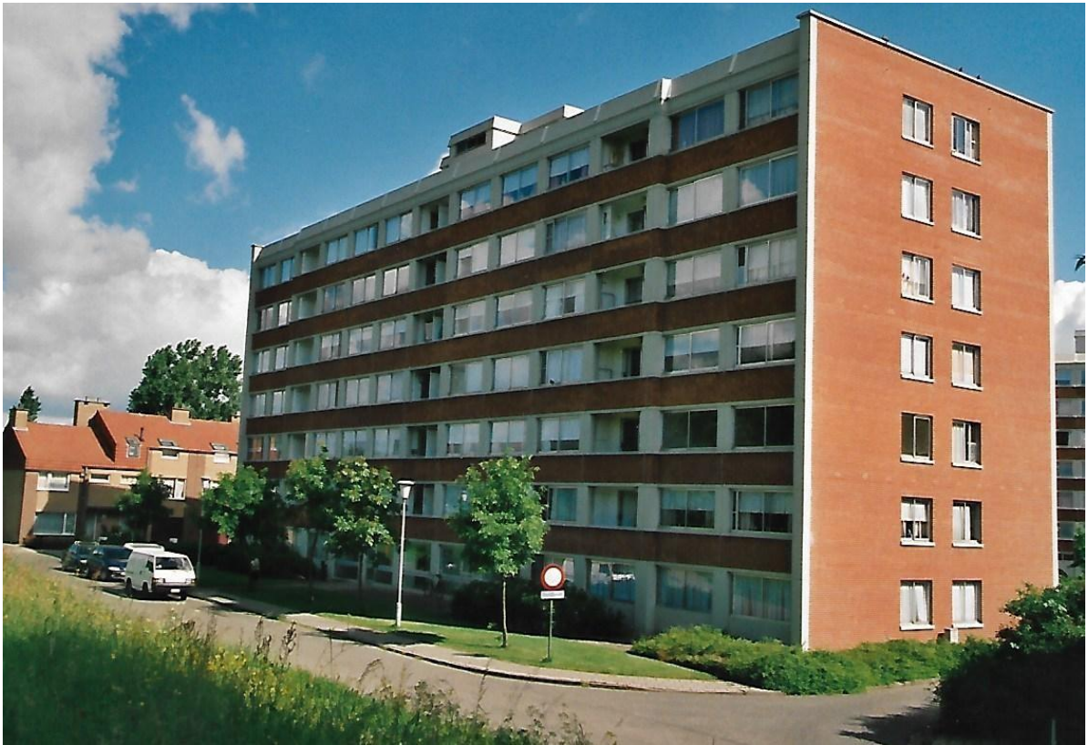
Appartementsgebouw van Goed Wonen.Rupelstreek aan de Populierenlaan (foto uit het jaar 2000)
